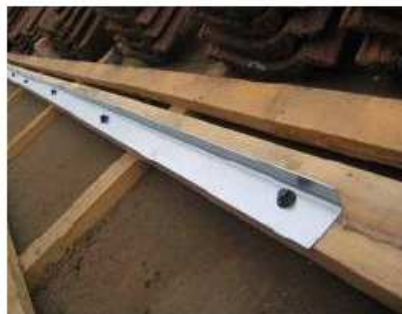
Plana, infällt montage på båda sidor av taket
